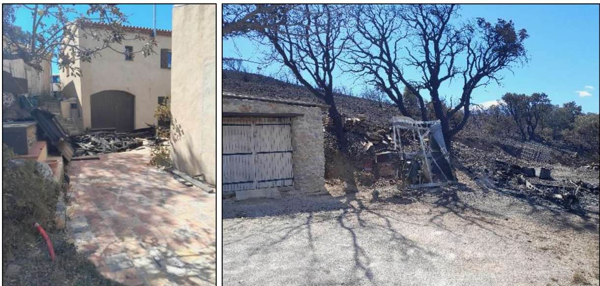
Dégâts extérieurs sur le Mas Del Payrou (commune de Castelnou)
