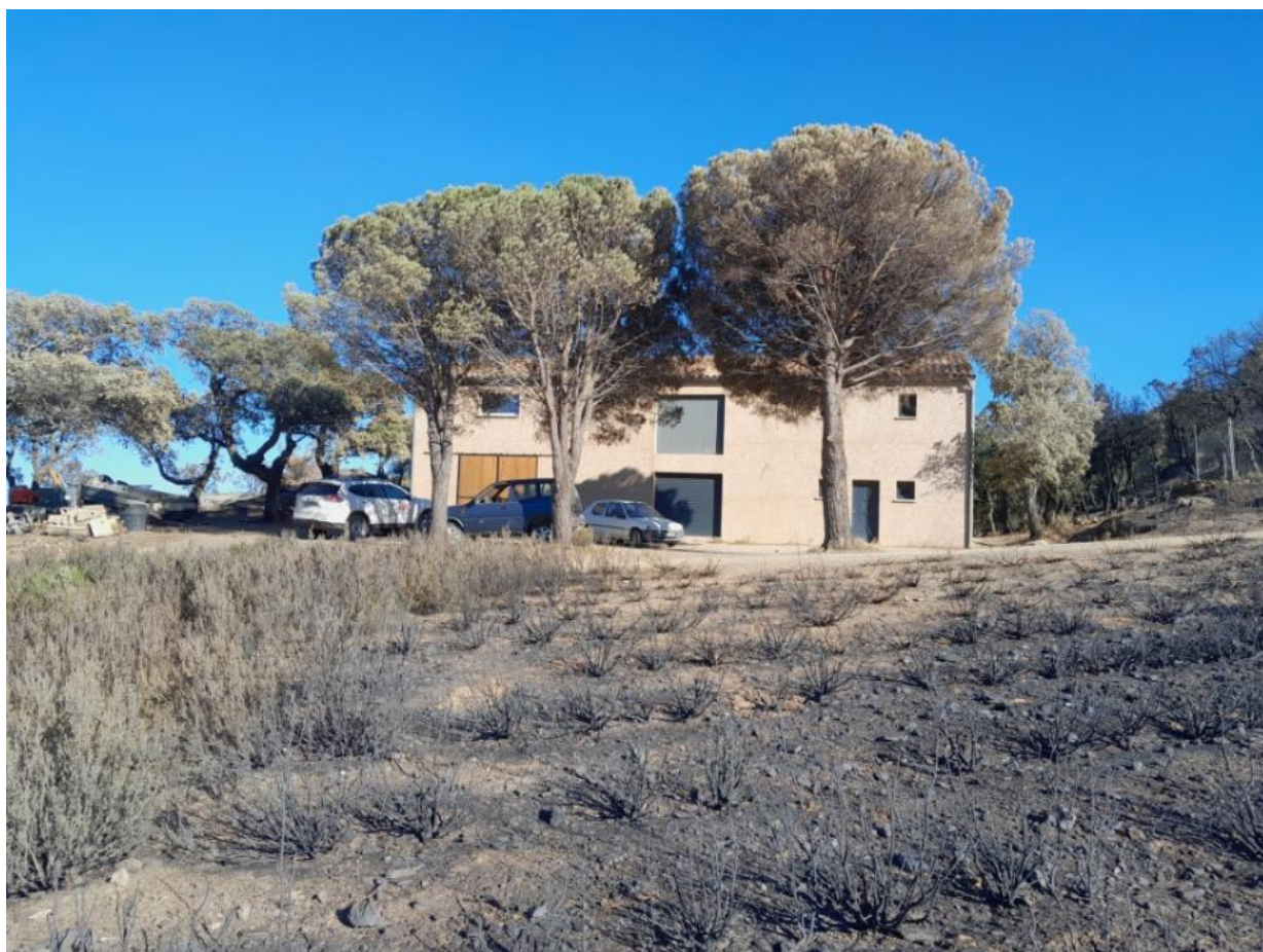
Mas sans nom (agriculteur – plantations aromatiques au premier plan) avec dégâts sur matériels périphériques extérieurs
